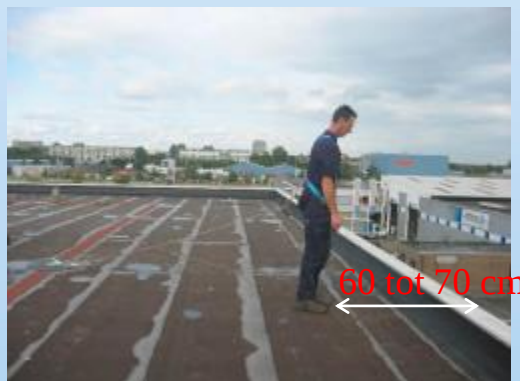
Hou ruim voor de dakrand halt en wijk niet meer dan 30 graden af van de haakse lijn
