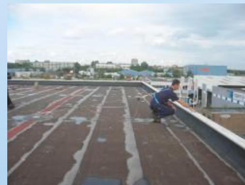
Voer de werkzaamheden uit in geknielde positie
