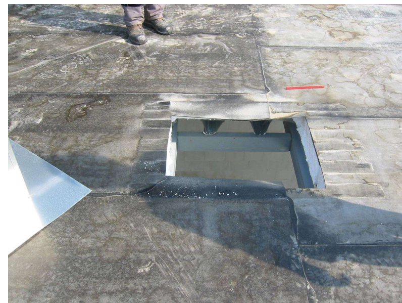
Afbeelding 4 Voorbeeld gemaakte sparing
