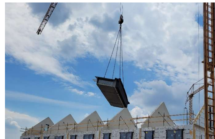
Afbeelding 15 Voorbeeld prefab dak
