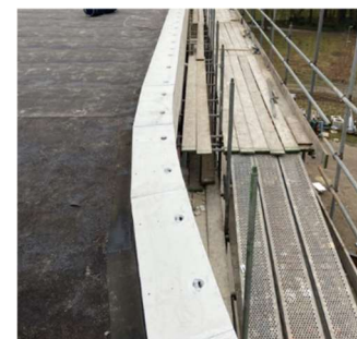
Afbeelding 21 Voorbeeld uitstekende (steiger)delen en te grote openingen
