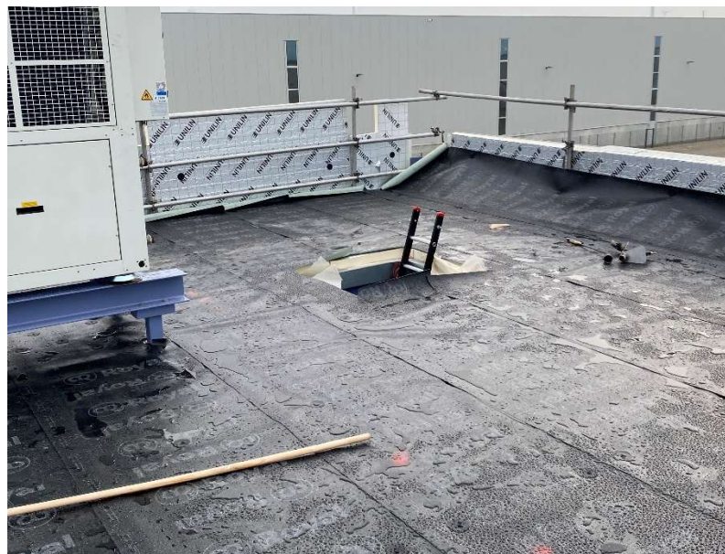
Afbeelding 17 Te korte ladder, niet geborgd en gevaarlijke uitstap
