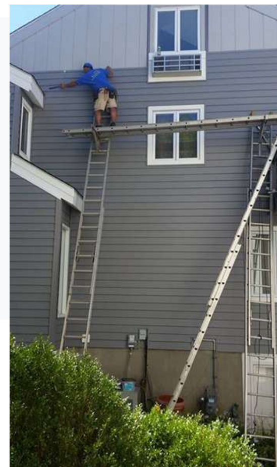
Afbeelding 21 Verkeerd ladder gebruik
